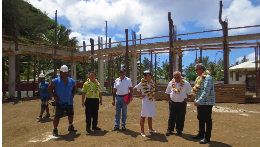
Point sur l'état d'avancement de la salle omnisports dans le village de Hauti
