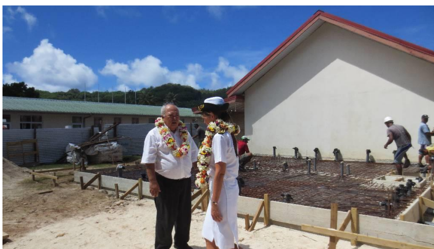
Chantier des sanitaires de l'école maternelle de Moerai
